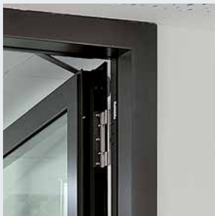
Zárubňa predpripravená pre horný zatvárač dverí
